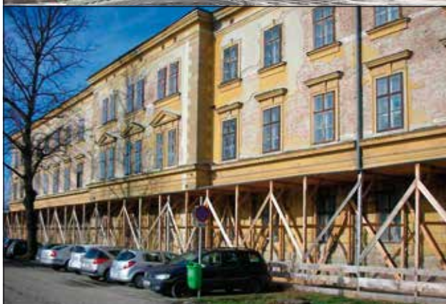
Die Jahnkaserne macht einem modernen Bau Platz.
