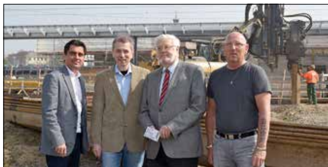
Bürgermeister Christian Gepp, GR Hannes Minatti, Baustadtrat Erik Mikura sowie GR Andreas Panek konnten sich bei der Besichtigung von der imposanten Baugrubenumschließung überzeugen.
