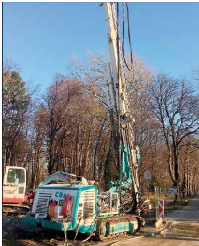
Bodenverdichtung mit Wasser, Sand und Zement auf eine Tiefe von rund sieben Metern mit einem Bohrkern und zwei Düsen, wobei das Gemisch mit einem Druck von 400 bar in das Erdreich injiziert wird.
